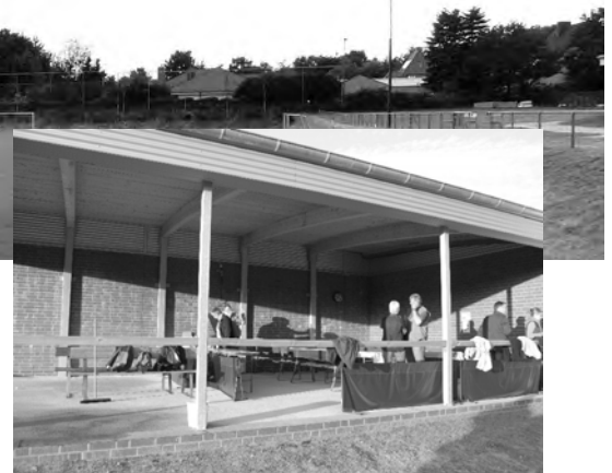
2011 Dachanbau an der neuen Sporthalle an der Schule
